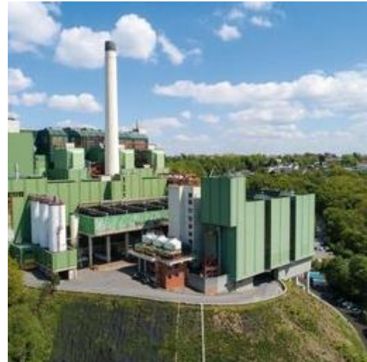
Bild 1: Müllheizkraftwerk Quelle: AWG Abfallwirtschaftsgesellschaft mbH Wuppertal
